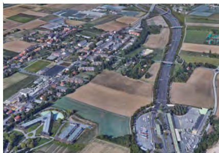
Figure 57 : vue sur les Ravières (GoogleEarth)
